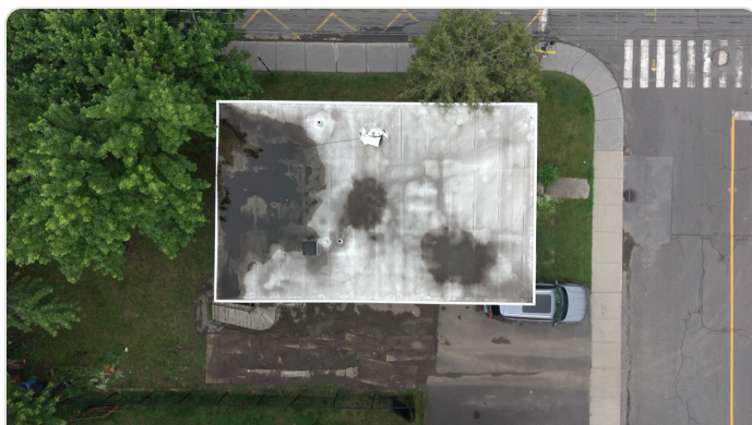
Vue de dessus — toit complet (sans annotation).
